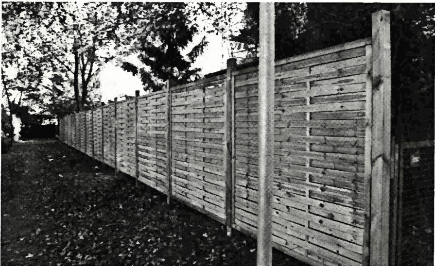
Bretterzaun zur Straßenseite der Soldauer Allee
