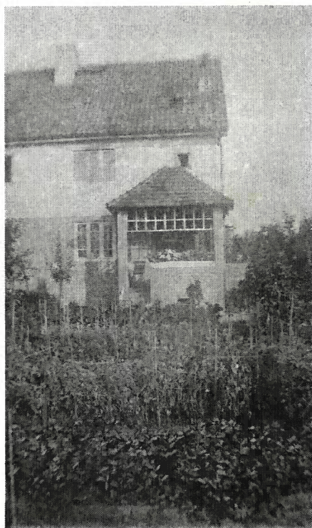
Ausbau der Veranda 1925 und ein echter Siedler-Garten. Der erdgeschossige Anbau zur Soldauer Allee fehlt noch.
