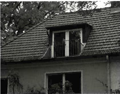
Beispiel für den 2.Rettungsweg aus dem Dachgeschoss mit „Zerschneidung“ des Walmdaches
