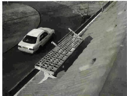
Beispiel für die denkmalverträgliche Sicherung des 2.Rettungsweges aus dem Dachgeschoss unter Erhaltung der vollständigen Dachfläche
